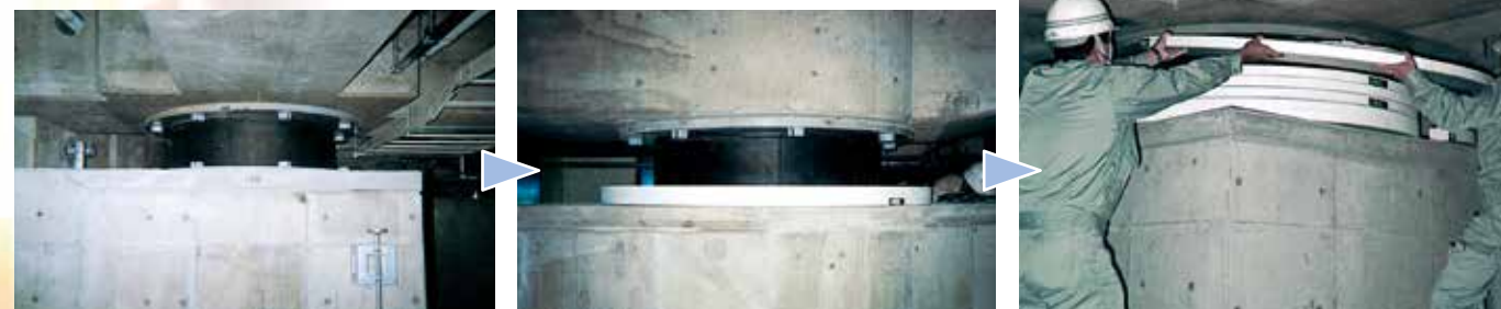
丸形積層ゴムの「護免火」耐火被覆工事(新築ビル)
