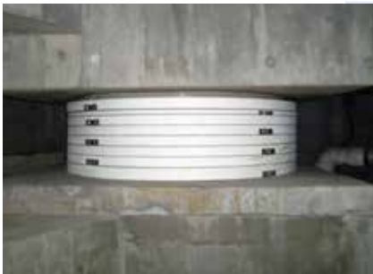
丸形積層ゴムの「護免火」耐火被覆工事(既設ビル)
