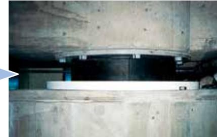
丸形積層ゴムの「護免火」耐火被覆工事(新築ビル)
