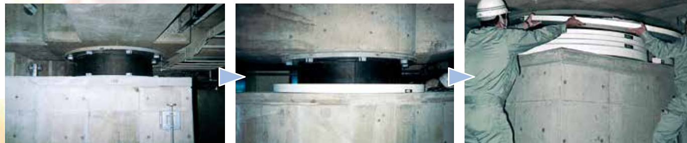
丸形積層ゴムの「護免火」耐火被覆工事
