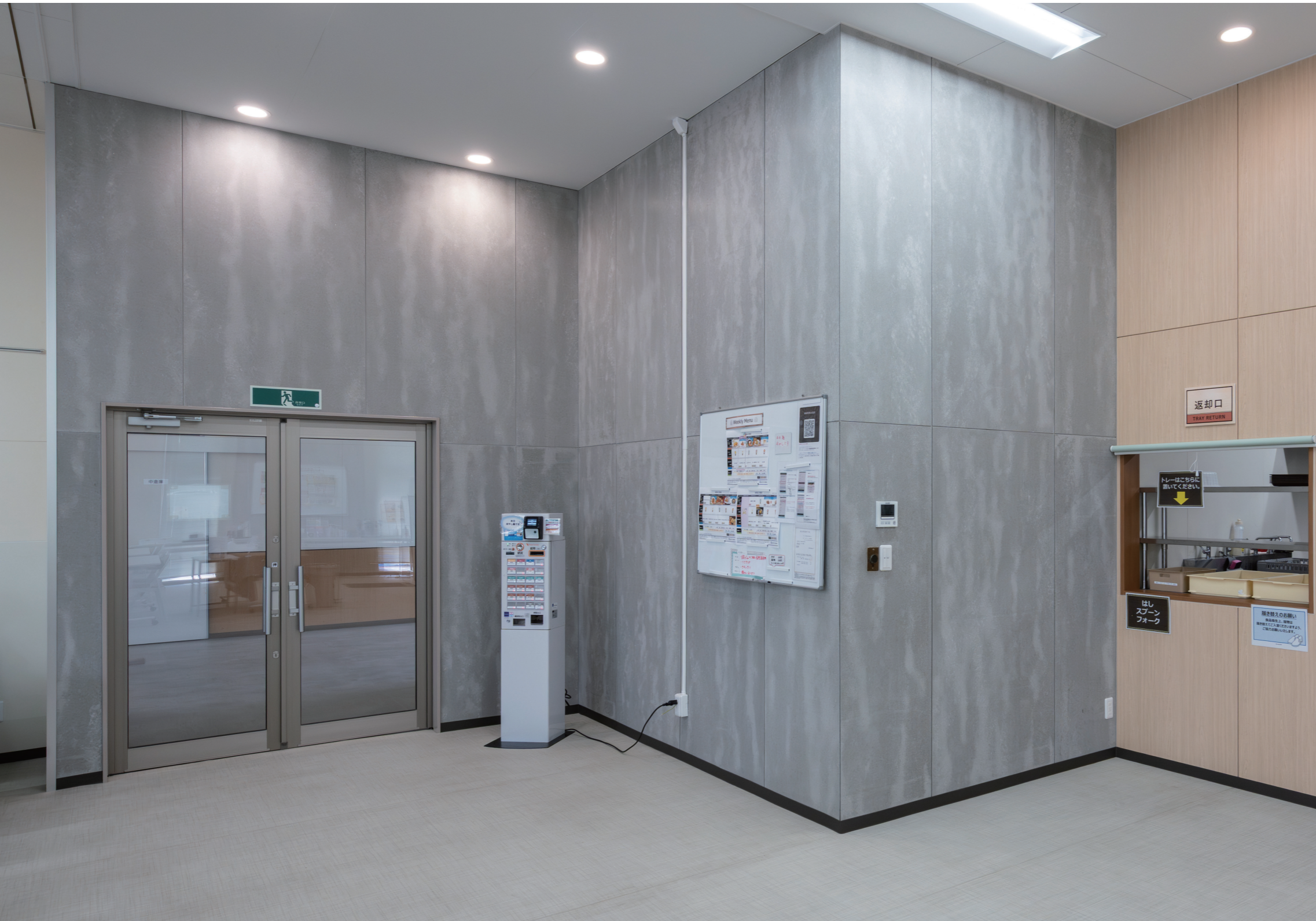
4m弱の天井高を活かした壁面構成。3×6板を縦に繋ぐことで、素材の持つ力強さとスケール感を強調している。
