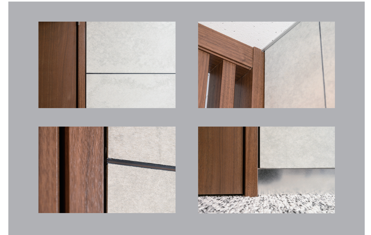
黒のT型ジョイナーを用いた目地。BEoNAの横張りとの組み合わせで、空間を引き締めた印象に仕上げている
